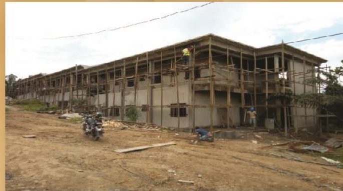
Travaux de construction du future Centre Missionnaire Verbum Dei
